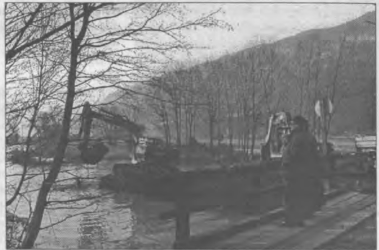
Die Gaisausanierung war Hans Oberthanner ein großes Anliegen
