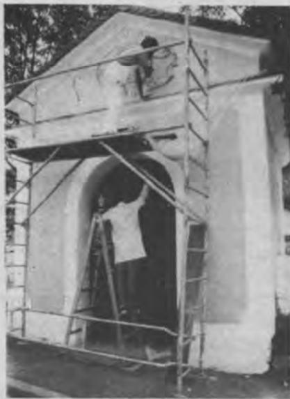
Die Restauratoren bei der Arbeit
