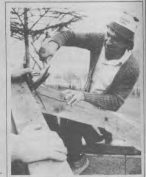
Kommandant Walter Gstrein beim Firstbaumsetzen am neuen Schlauchturn
